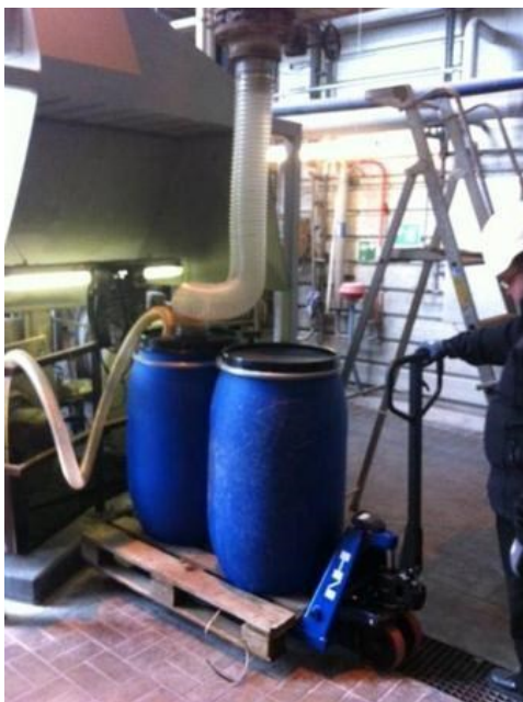
BILLEDE 10: UDTAGNING AF WET RGA (FLYVEASKE) PRØVER PÅ VESTFORBRÆNDING ANLÆG 5
