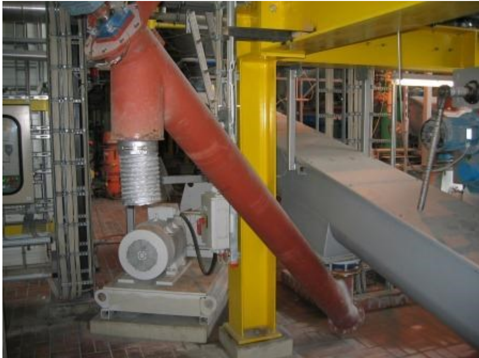
Figur 7: Prøveudtagningssted for flyveaske (tørt RGA) fra ovne nr. 1- 4 og ovn nr. 6
