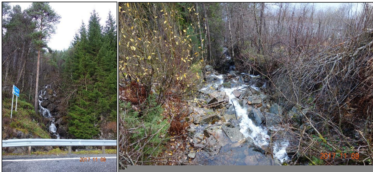
Figur 13: Hållåvåbekken. Til venstre: bekkeløp på oversiden av fylkesveg. Til høyre: Bekkeløp på nedsiden av fylkesveg. Sidekanter er berg, en del stein i selve løpet.
