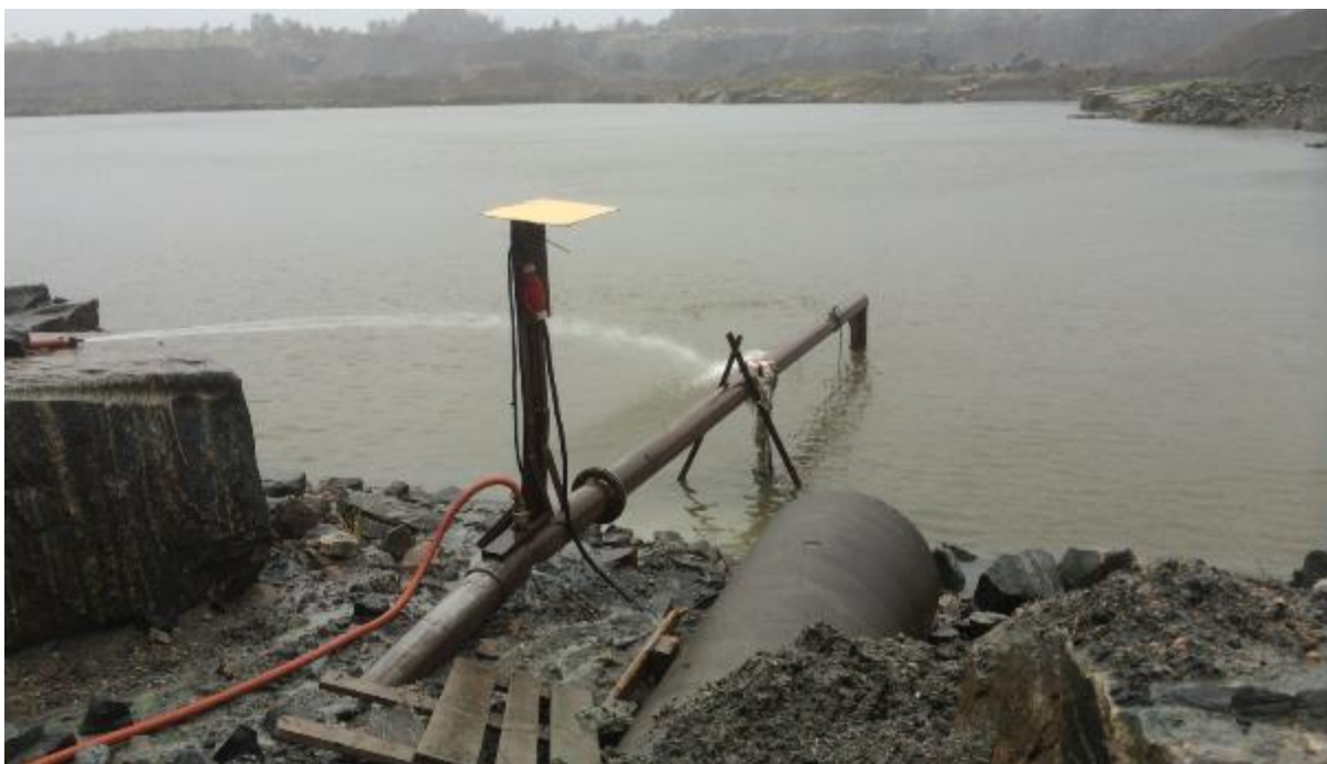
Figur 15 Eksisterende sedimenteringsdam med pumpeanlegg til sjø
