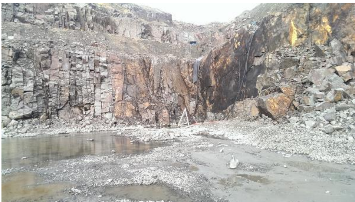
Figur 26. Nordvestlig hjørne av dagbruddet under befaring 22. oktober, 2015. Legg merke til mørke partier på veggene, med jern- og manganutfellinger (foto: K.J.Tuttle).
