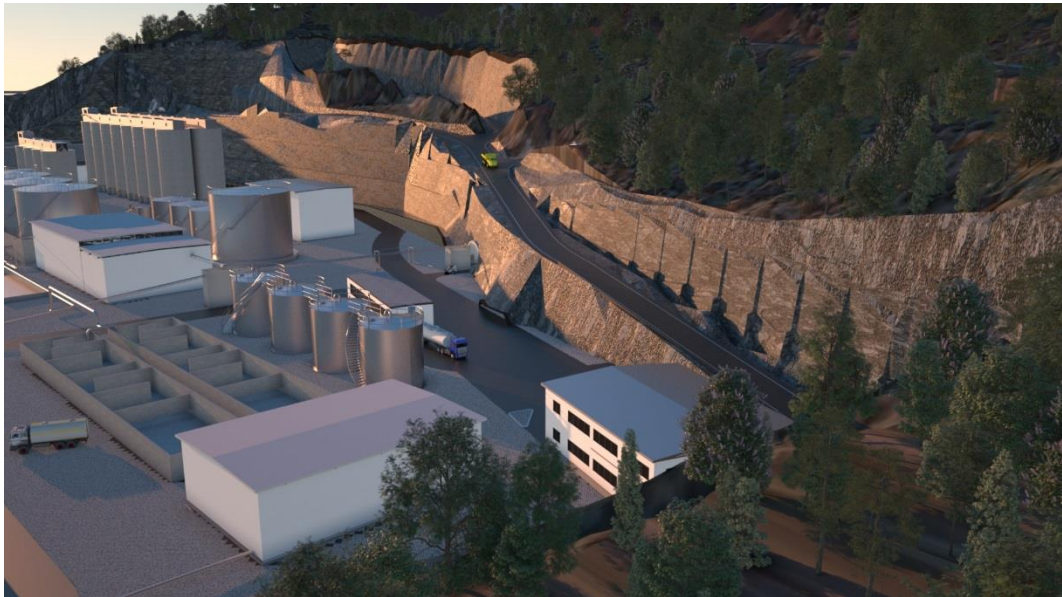
Figur 24: Anlegget sett fra nord
