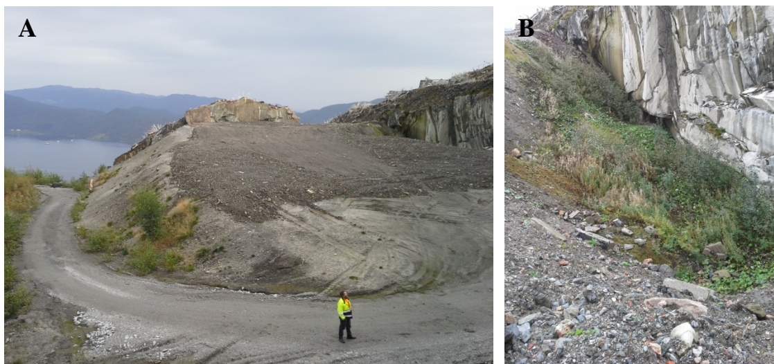
Bilde 1: bilde A viser overflaten på Deponi 1 og adkomstveien til deponiet. Bilde B viser gjenværende forsenkning i terrenget hvor vannet trolig infiltrerer direkte til gruvegangene.
