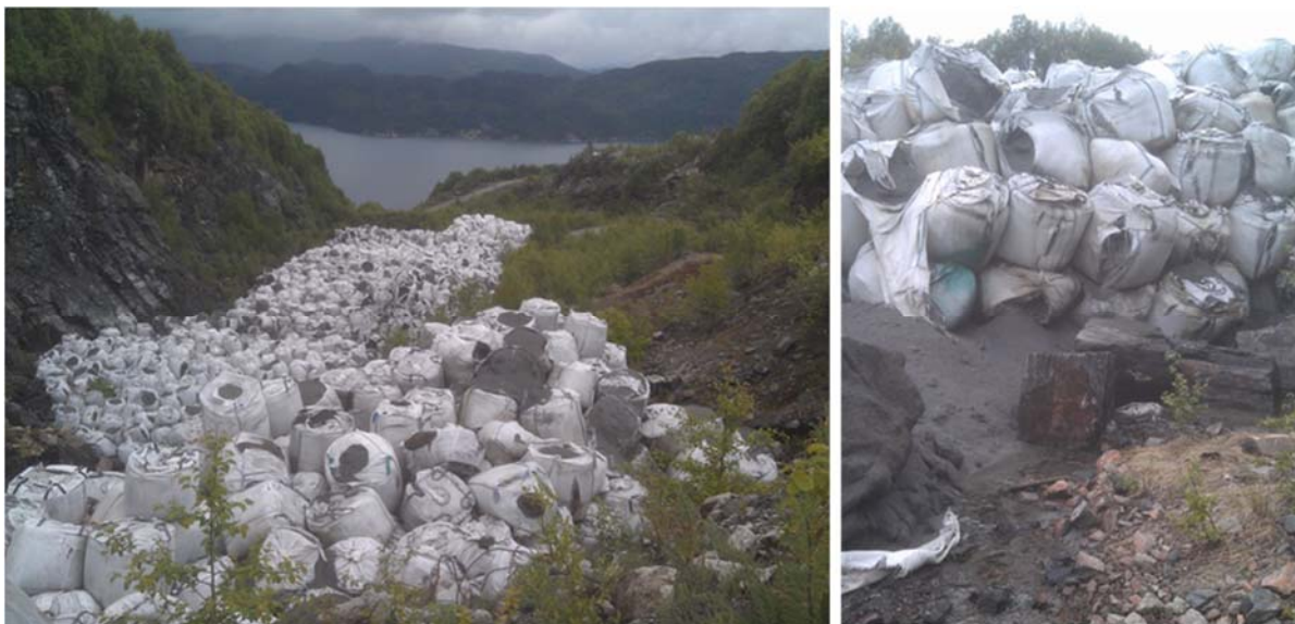
Bilde 2: oversiktsbilde av deponi 2, hvor storesekker med møllestøv er deponert. Bilde til høyre viser hvordan sigevannet renner tett gjennom deponert møllestøv før det ledes til gruvegangene.
