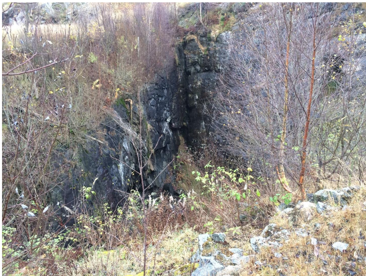
Figur 6. Bilde av østre del av deponi nr 3, sett i sørøstlig retning. I dette området har det rast og det er allerede deponert avfallsmasser av ukjent kvalitet.
