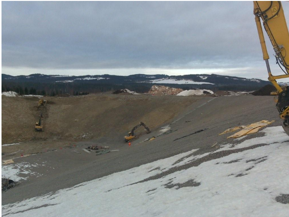
Figur 21. Typisk oppbygging av et deponi av samme type som for Deponi nr 4
